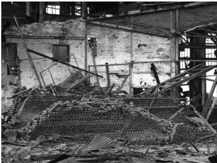
Разрушенный цех фабрики полых изделий АО «Везер», г. Бремен
